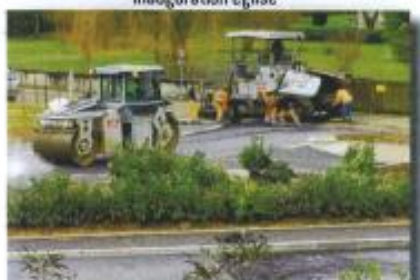
les travaux sur la RD 3
